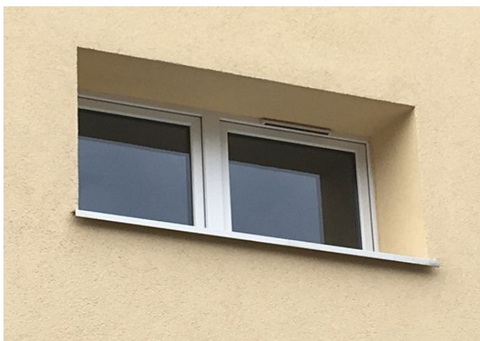
Okno z nawiewnikiem powietrza w bloku
