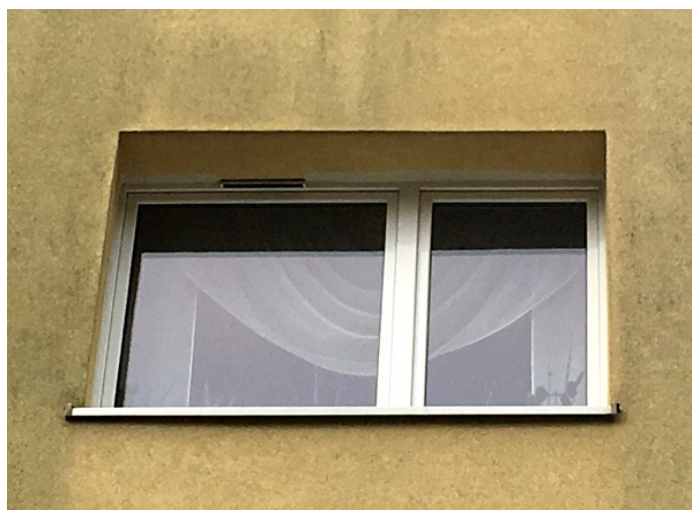
Okno z nawiewnikiem powietrza w bloku
